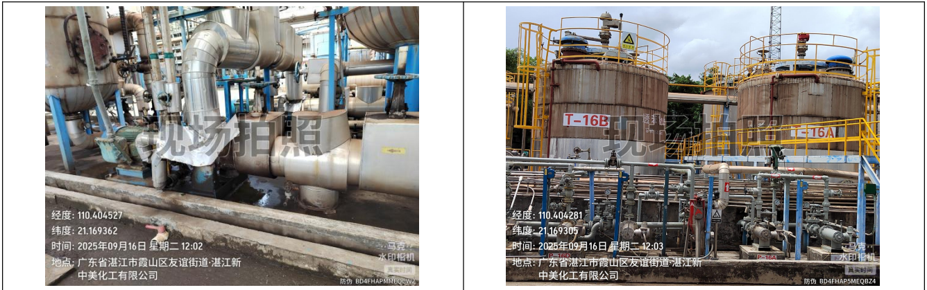
图 4.1-3 泵运输现场照片
